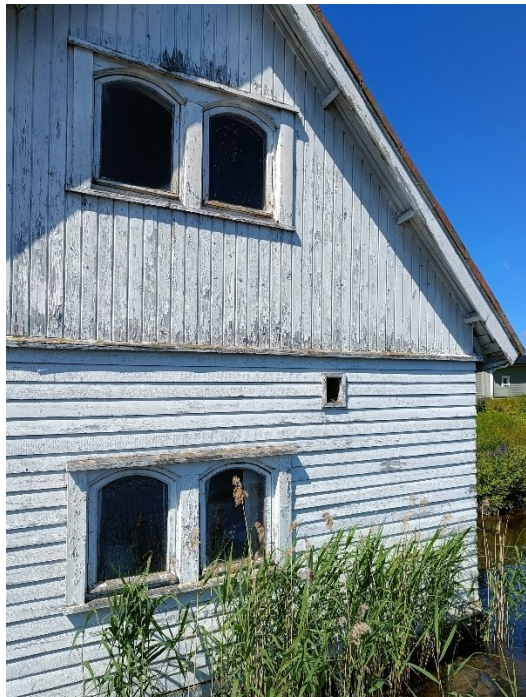
Kuva 6. Saunan järven puoleinen julkisivu. Pienestä ikkunasta voi katsella järvelle lauteilta. © Tampereen kaupunki 2025
